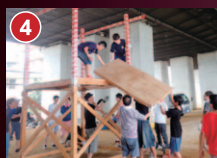
④ 床板をセットして
