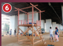
⑥ 梯子をつけて骨組み完成
