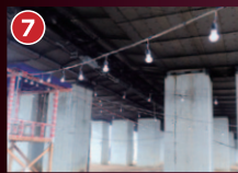
⑦ 配線&電球を取り付ける
